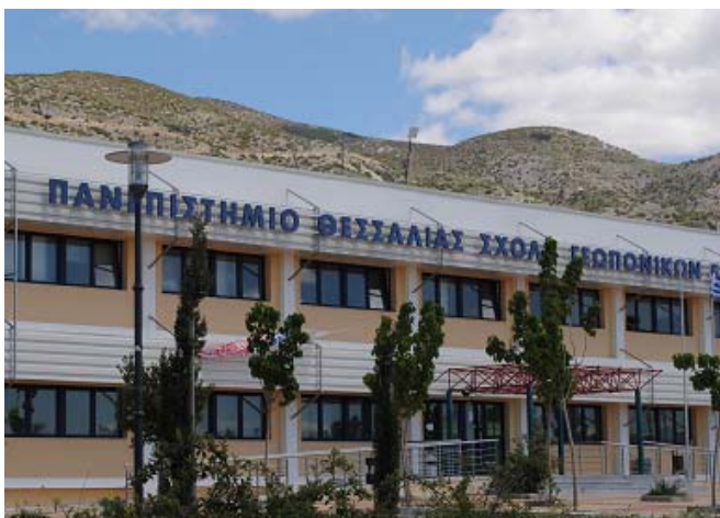
Το κτήριο της Σχολής Γεωπονικών Επιστημών Πανεπιστημίου Θεσσαλίας
